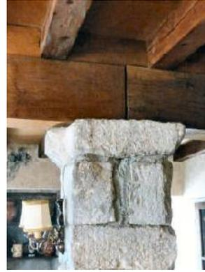
*Le pilier de pierre, au centre d'une grande pièce, supporte une poutre porteuse de solives carrées pour le plancher.*
