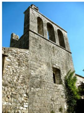
*Le mur occidental vient buter contre l'abside en bouchant une partie de l'embrasure de la fenêtre. Celle-ci a été mise en place après la construction de l'abside, au vu du raccord approximatif entre les pierres de la fenêtre et le mur.*
