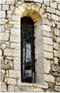
*Claveaux en pierres jaunes de la fenêtre du fond de l'abside. Les raccords sont imparfaits entre l'arc, les pieds-droits et le mur ce qui prouve que la fenêtre a été placée après la construction du mur.*
