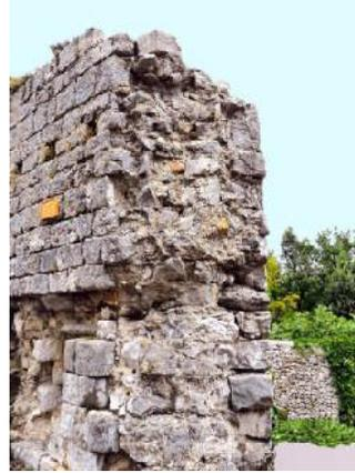
*Coupe du rempart où se distingue bien le parement et le remplissage. (N° 12 du Plan)*
